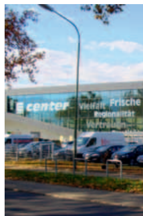
FREIBURG LÖRRACHER STRASSE
